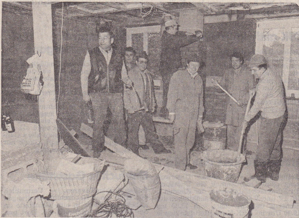
Einer Baustelle gleicht zur Zeit noch das neue Vereinsheim des Angelsportvereins Süggerath in Beeck, wo die Mitglieder in ihrer Freizeit kräftig mit anpacken.
